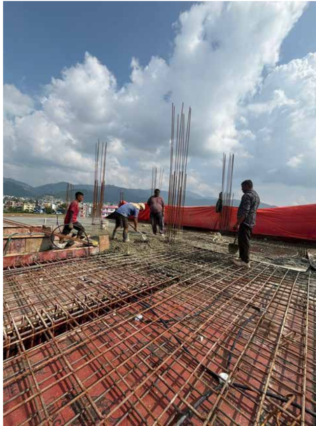
Betonplatzierung während des Gießens der Platte im vierten Stock.
