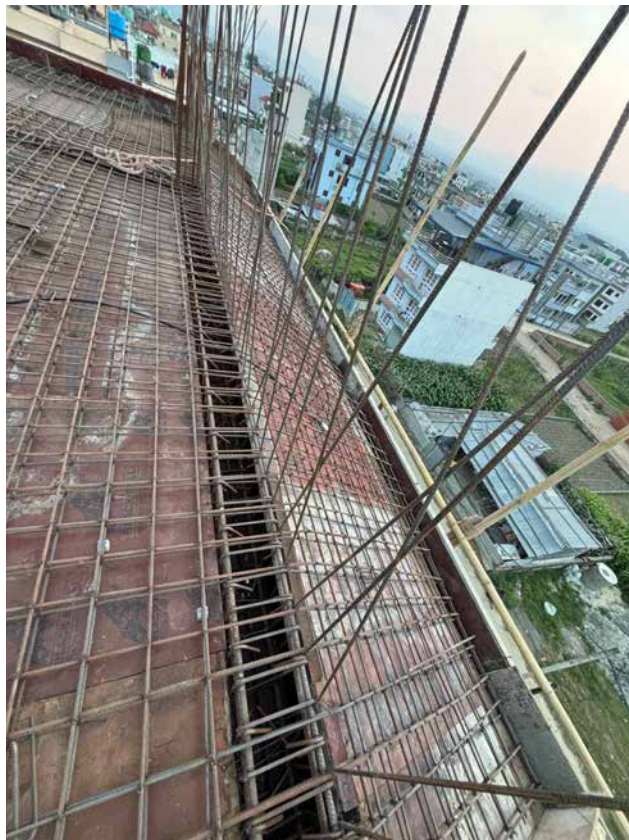
Nahaufnahme von Verstärkung und Balkenanordnung.
