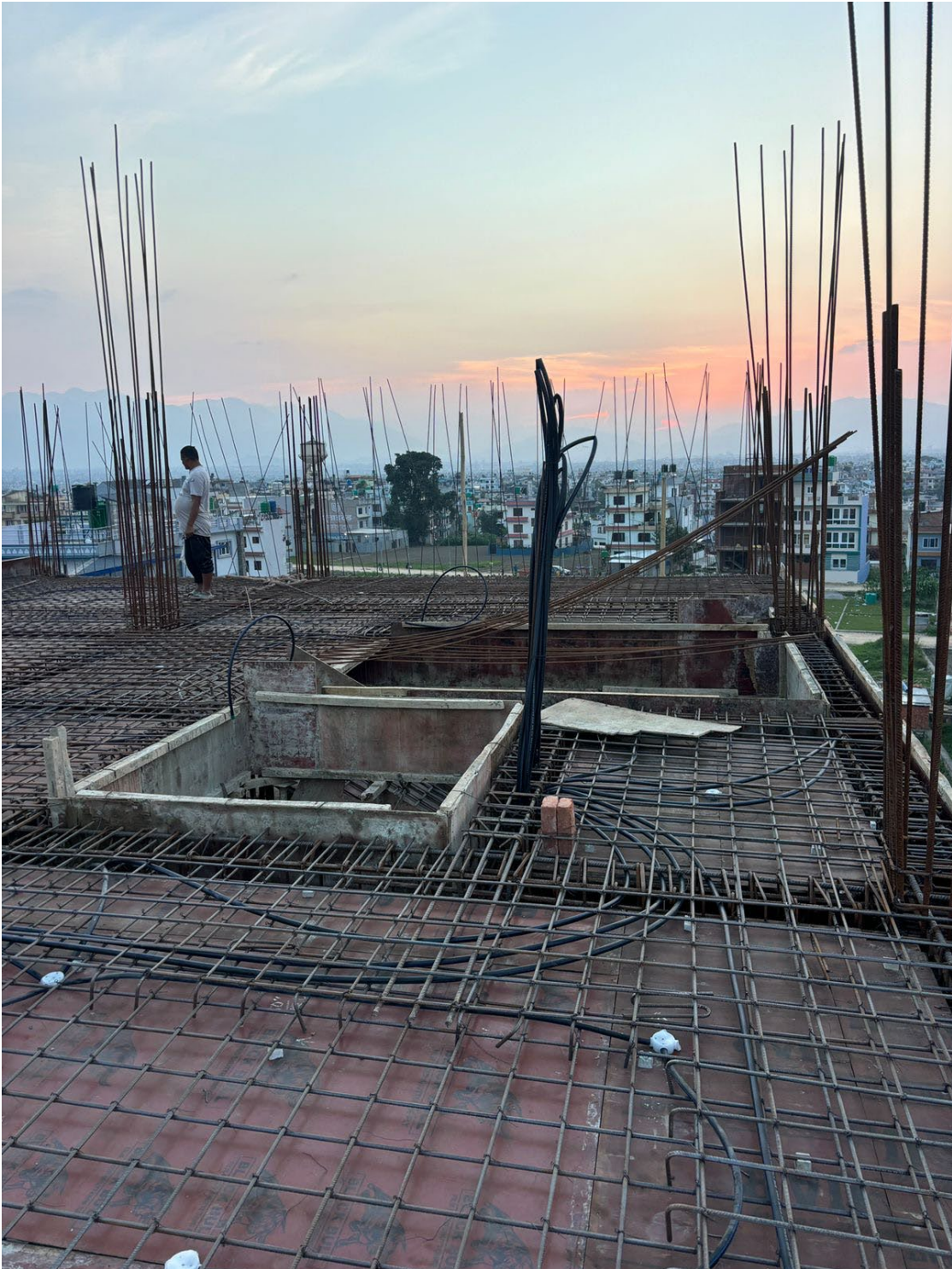
Verstärkungsstahl und Schalung werden vor dem Gießen der Platte im vierten Stock vorbereitet.
