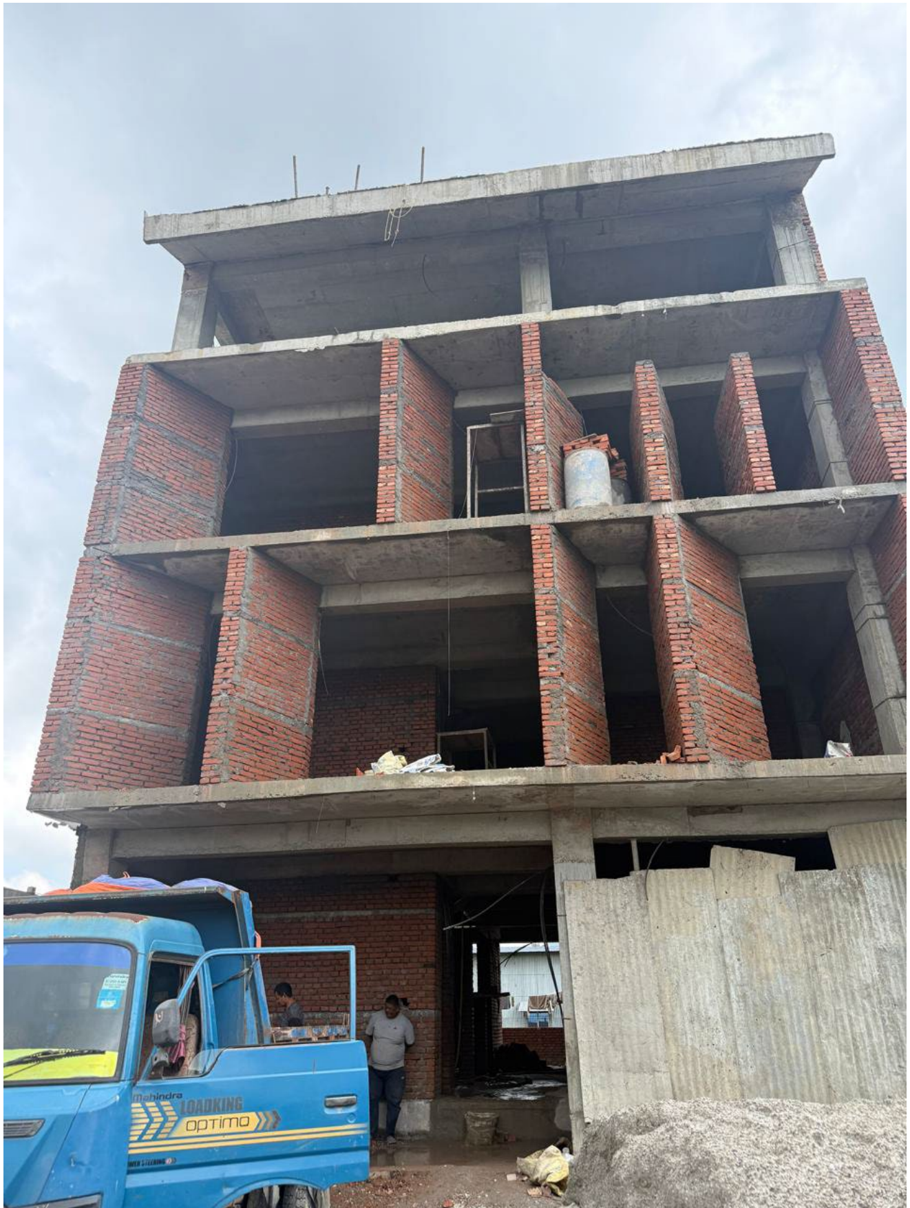
Die Baustruktur schreitet auf die Fertigstellung zu.
