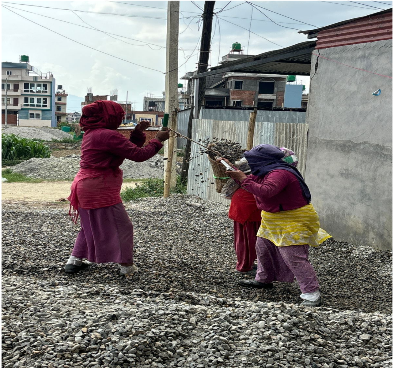
Bauarbeiter bereiten Aggregate und Baumaterialien vor.
