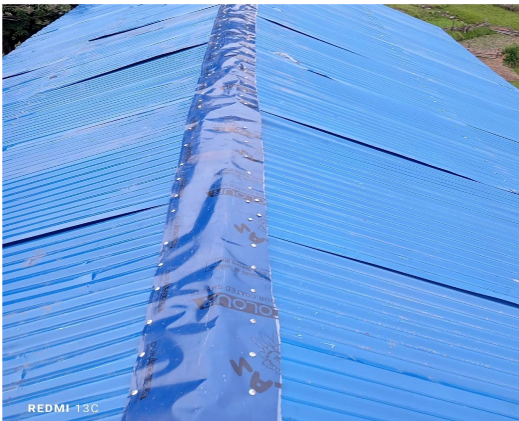
Neues Dach der Schule
