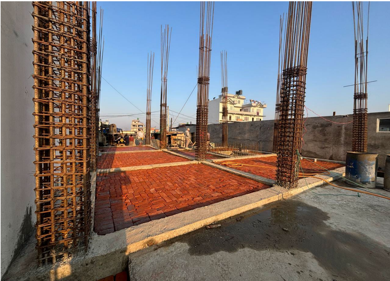
Foto: Baufortschritt Foto in der Theo Eye Clinic Bhaktapur
