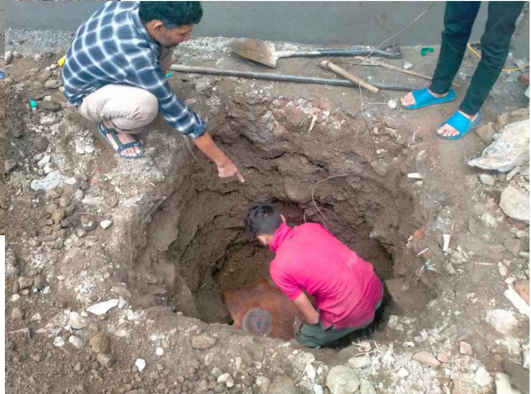
Loch graben für Elektrische Erdung.
