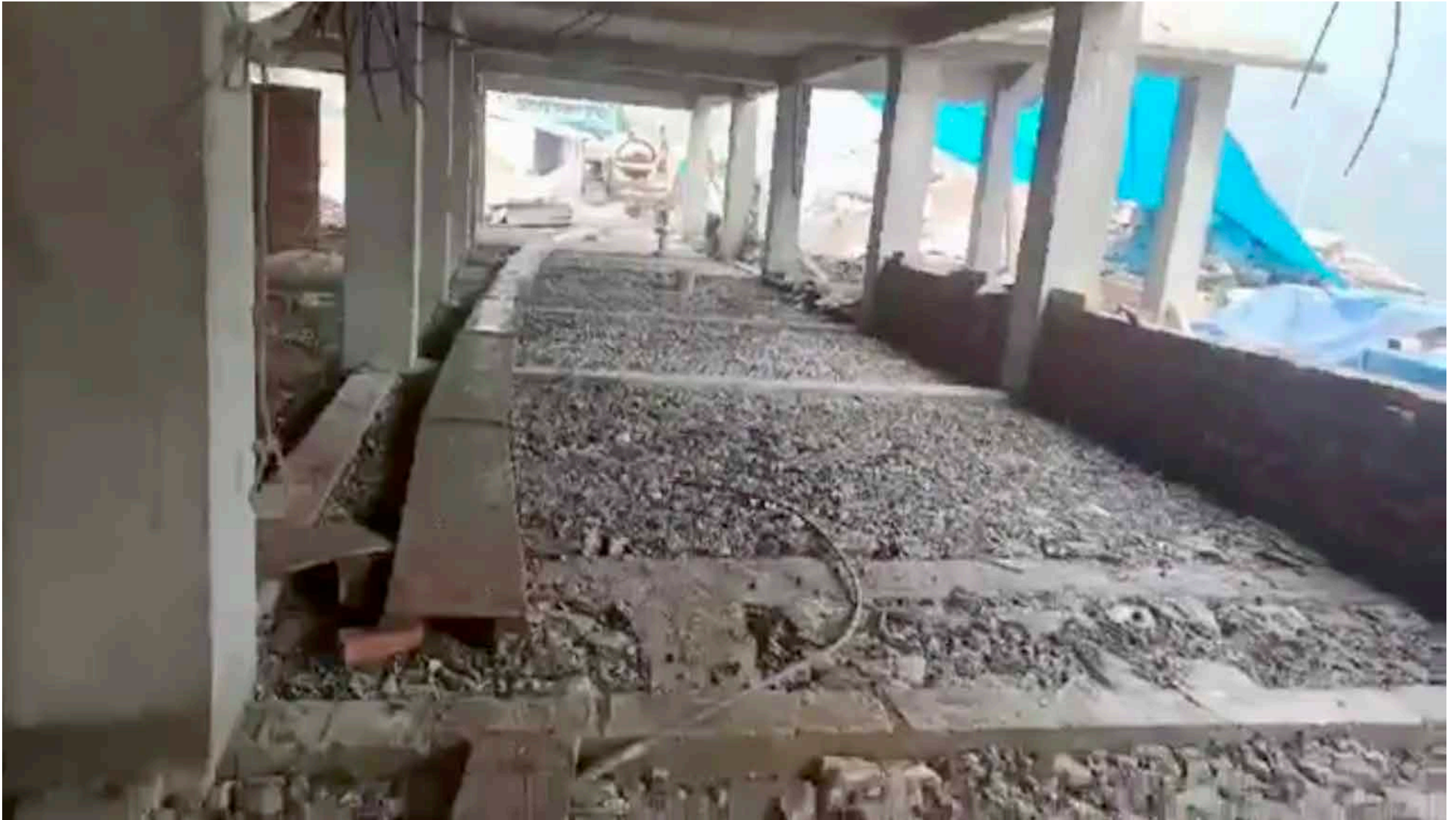
Nach der Backsteinmauer. Steine am Fuß des Erdgeschosses legen, bevor Beton darüber gegossen wurde.
