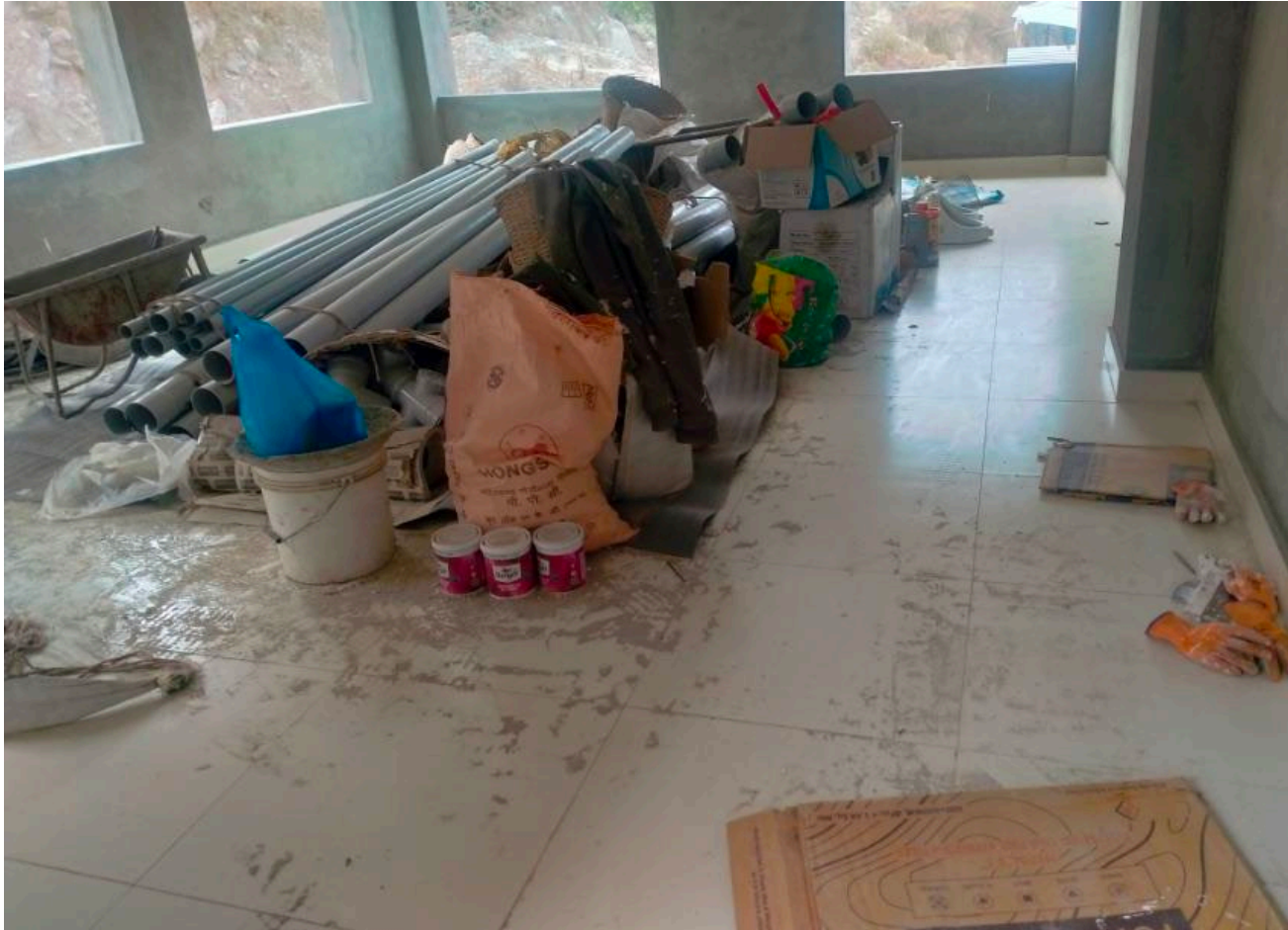
Die Materialien werden vor Baubeginn im Gebäude ausgelegt.
