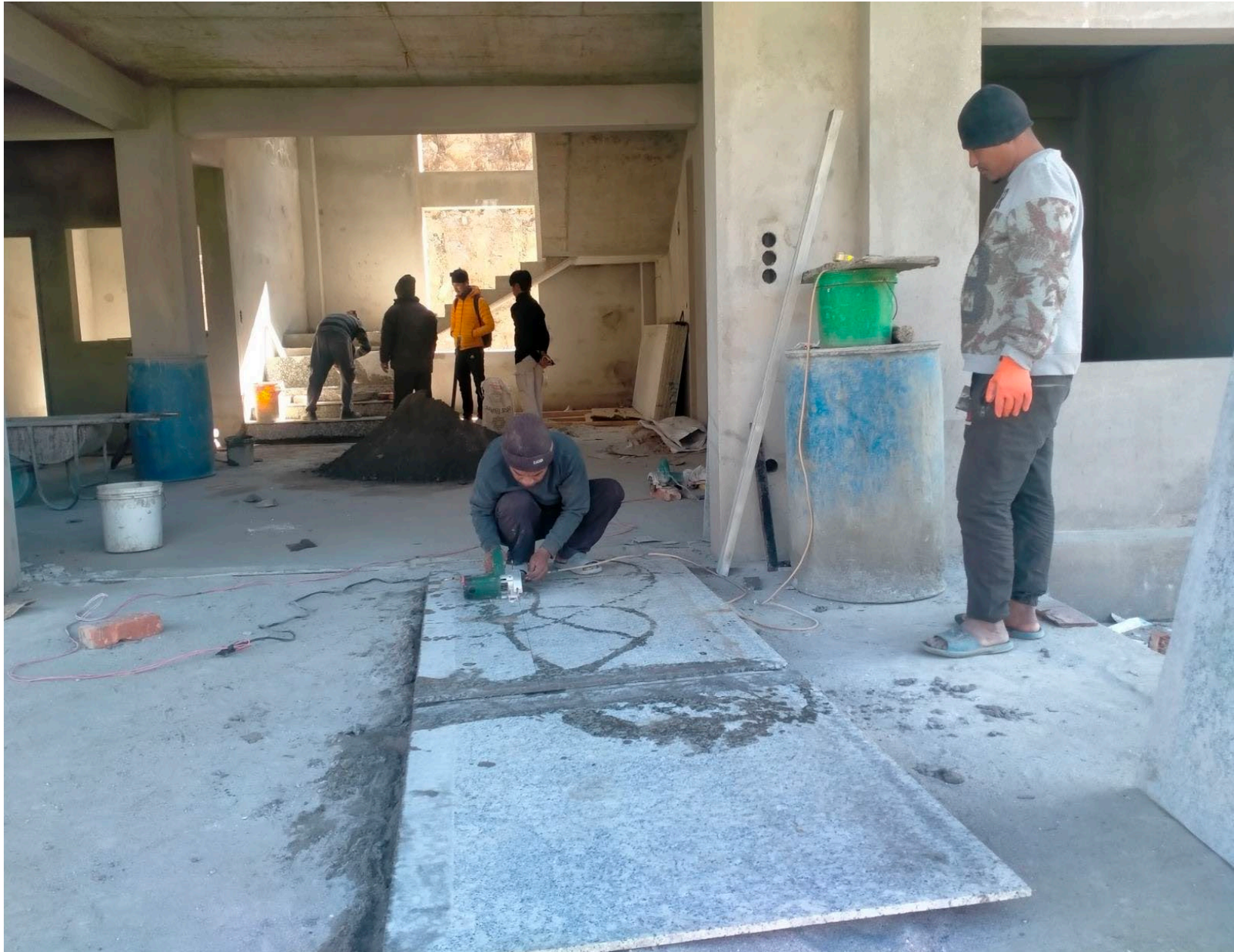
Marmor auf die Stufen der Treppe zu schneiden.
