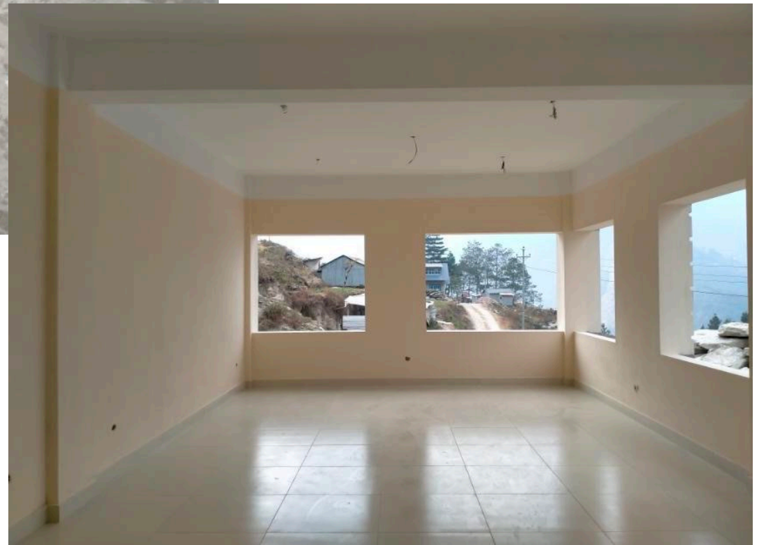
Abschluss der Marmor- und Flieseninstallation für Treppen und Räume. Auch einige Räume sind komplett gemalt.
