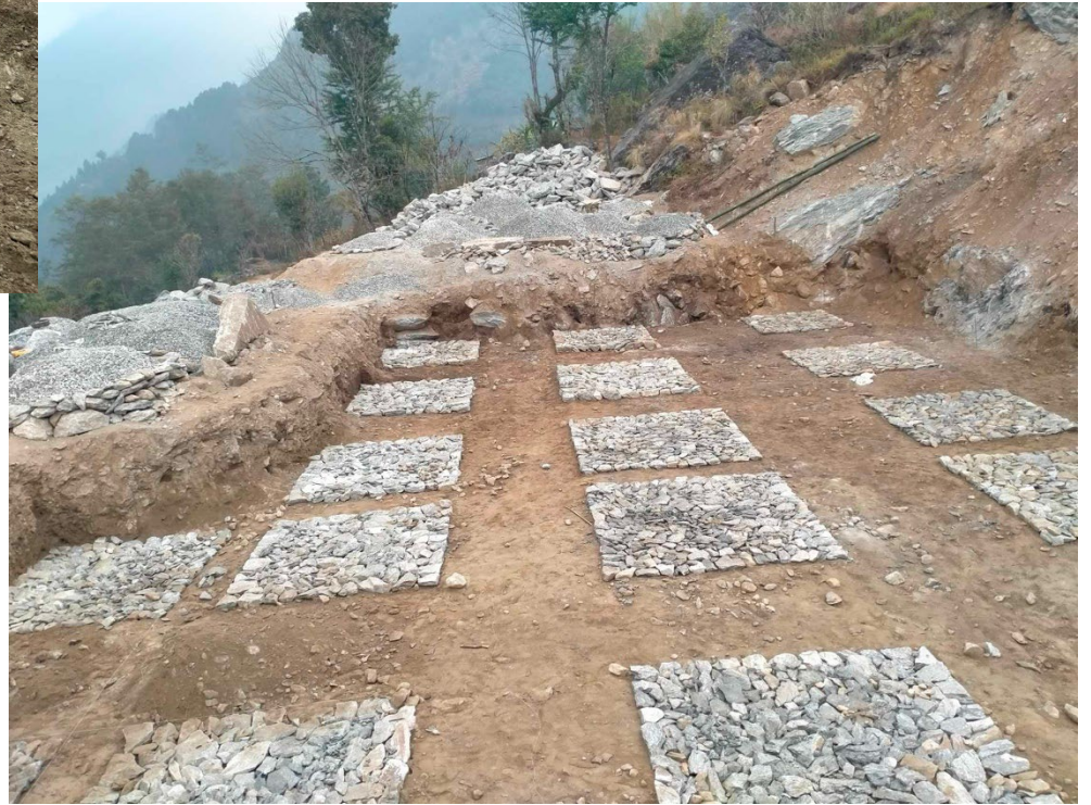
Abflachung des Bodens für das Fundament.
