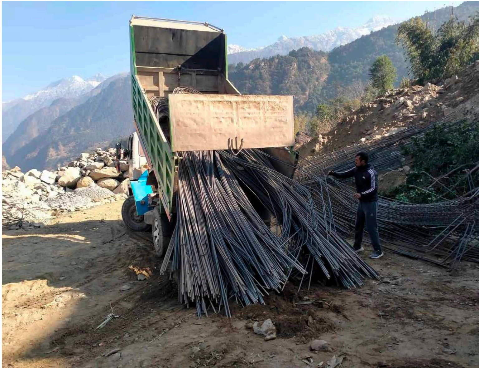
Die zweite Ladung der Eisenstangen wird an der Baustelle abgeladen.
