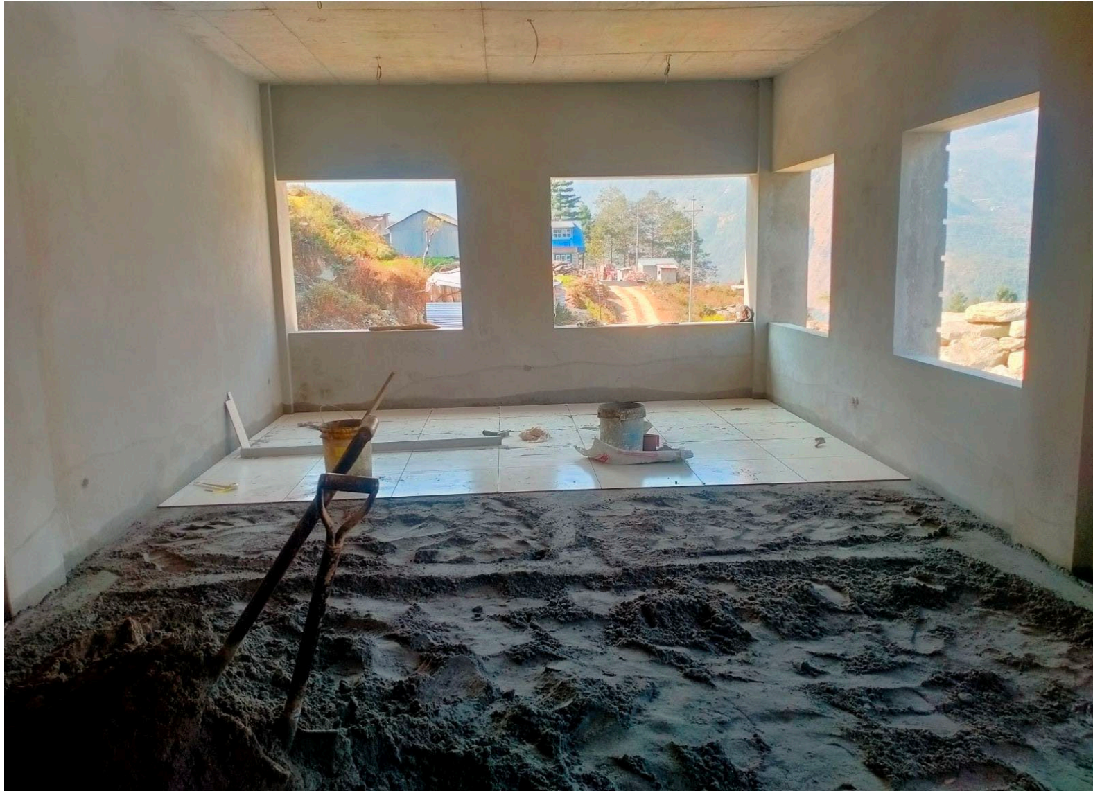
Grundlagenzementmischung vor dem Verlegen der Fliesen.
