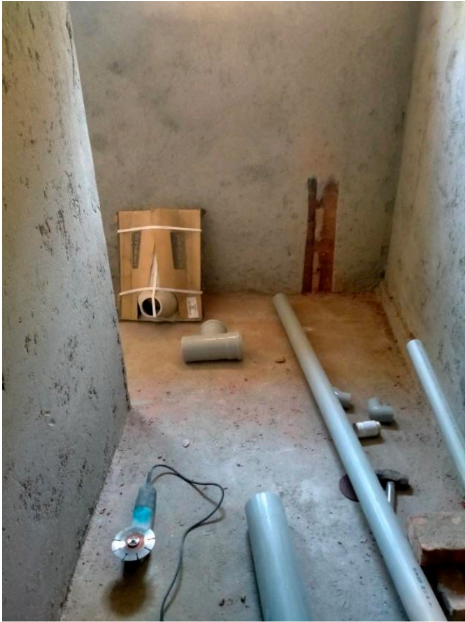
Vorbereitung eines Rohrs für die Toilette.
