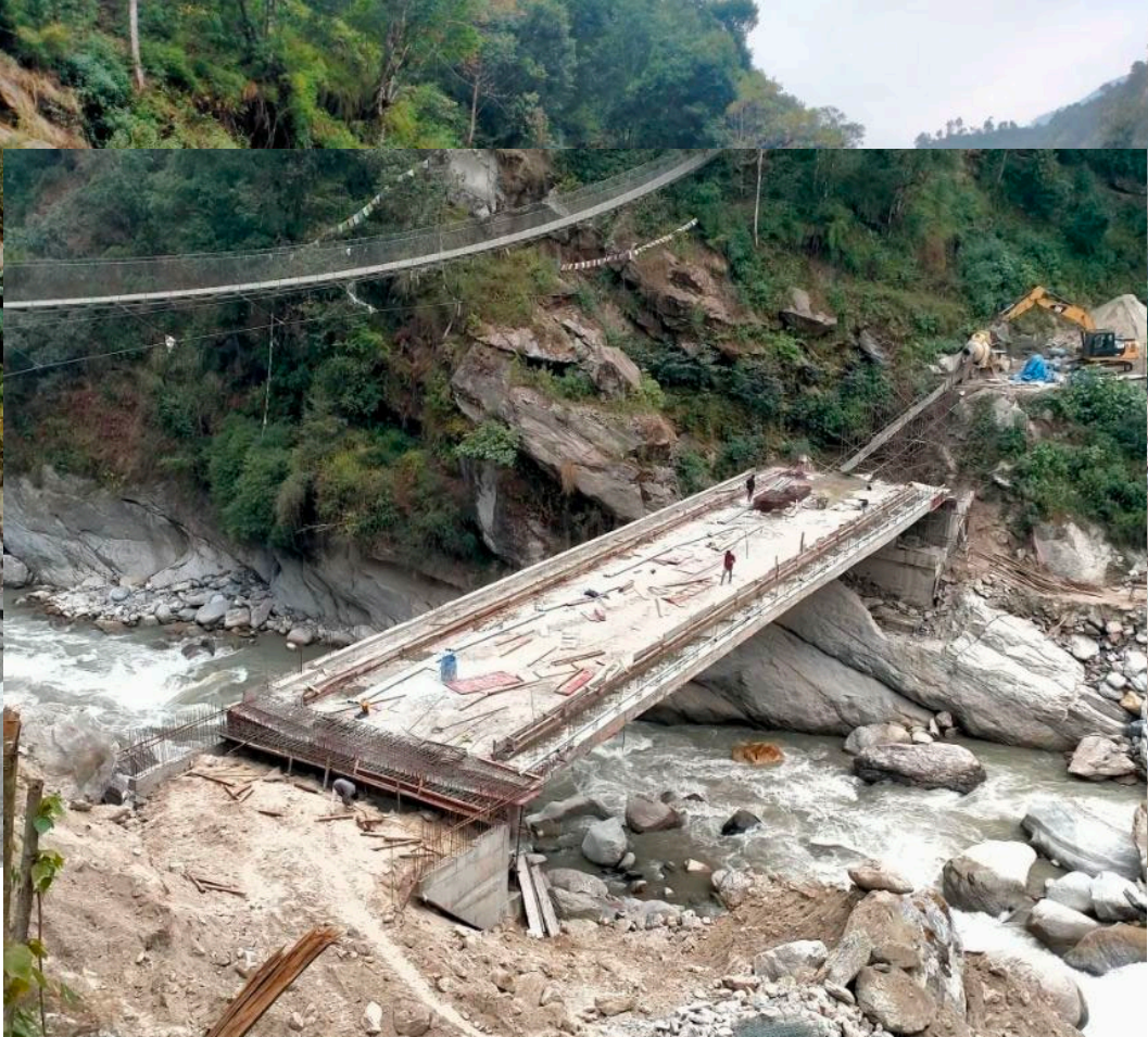
Aktueller Stand des Baus der Juving-Brücke.
