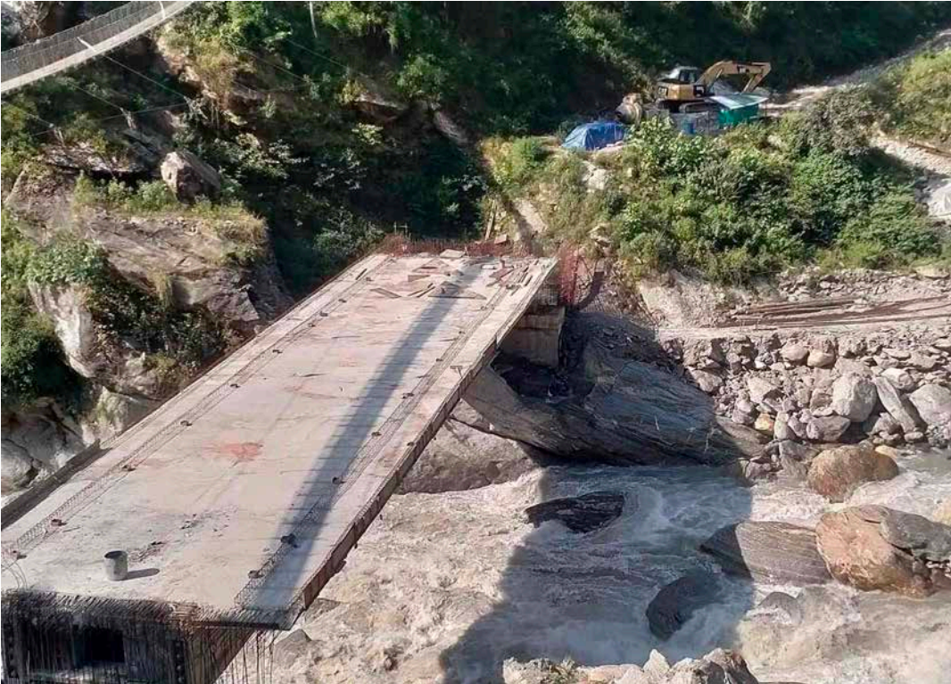
Aktueller Stand der Brücke, die Juvina und Thaksindu verbindet.
