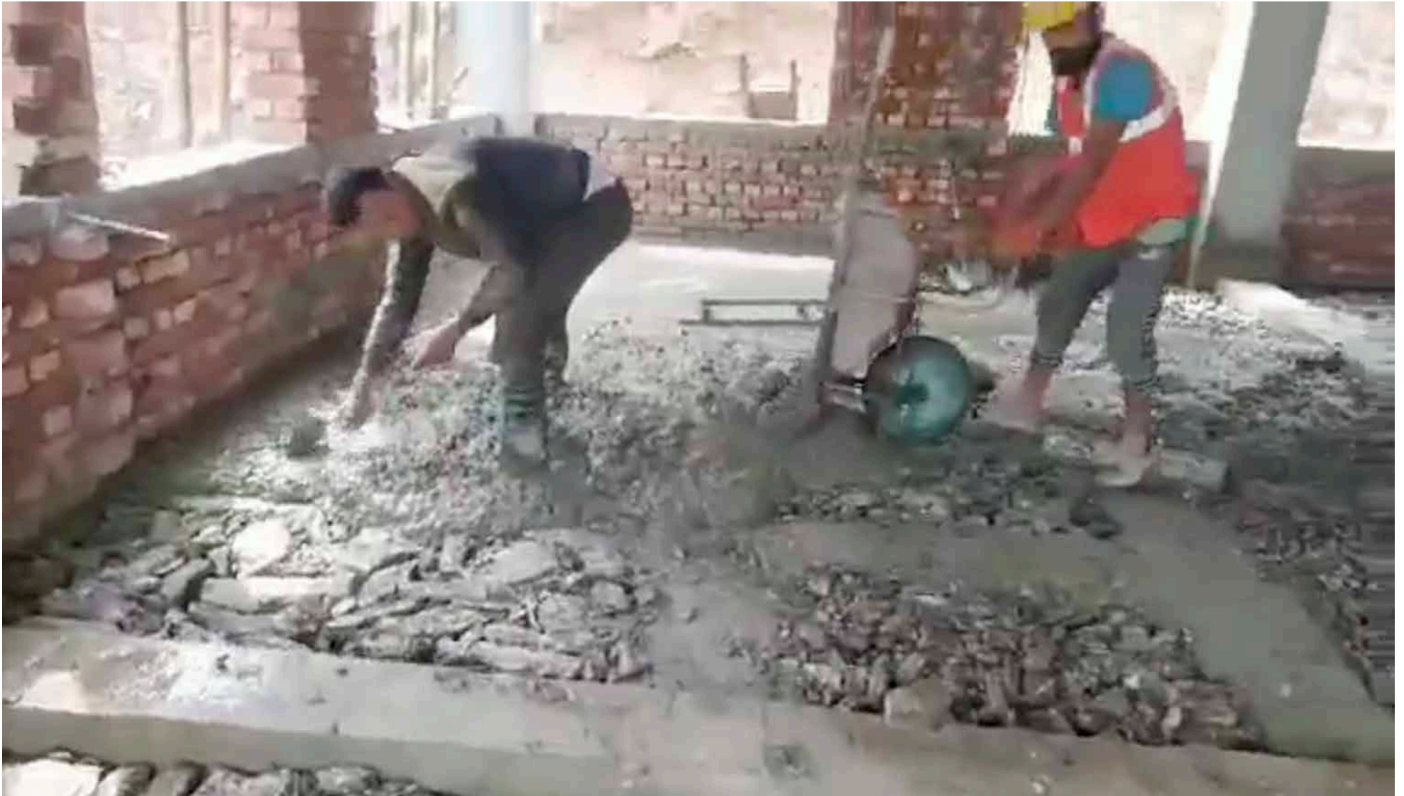
Gießen von Beton und Glätten
