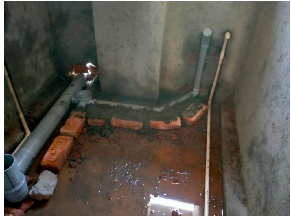
Vorbereitung der Wasserleitungen für die Toilette.
