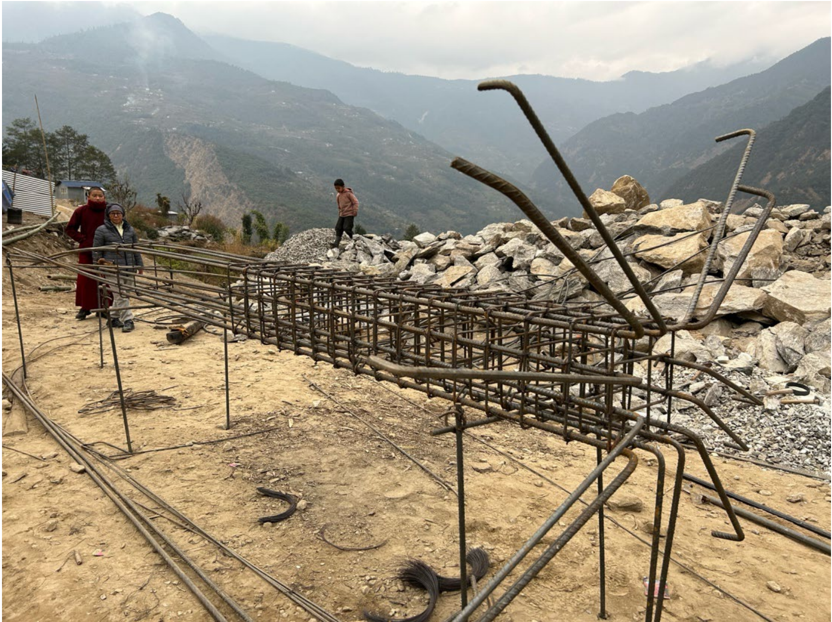
Die erste Ladung Eisenstangen für Fundament und Säulen vorbereitet.
