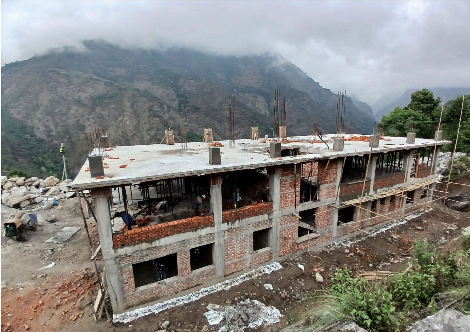
Übersicht über die Ziegelmauer im Erdgeschoss und im ersten Obergeschoss.
