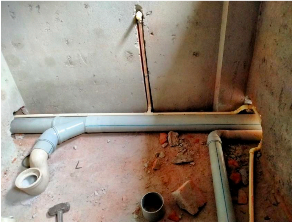
Vorbereitung der Wasserleitungen für die Toilette.
