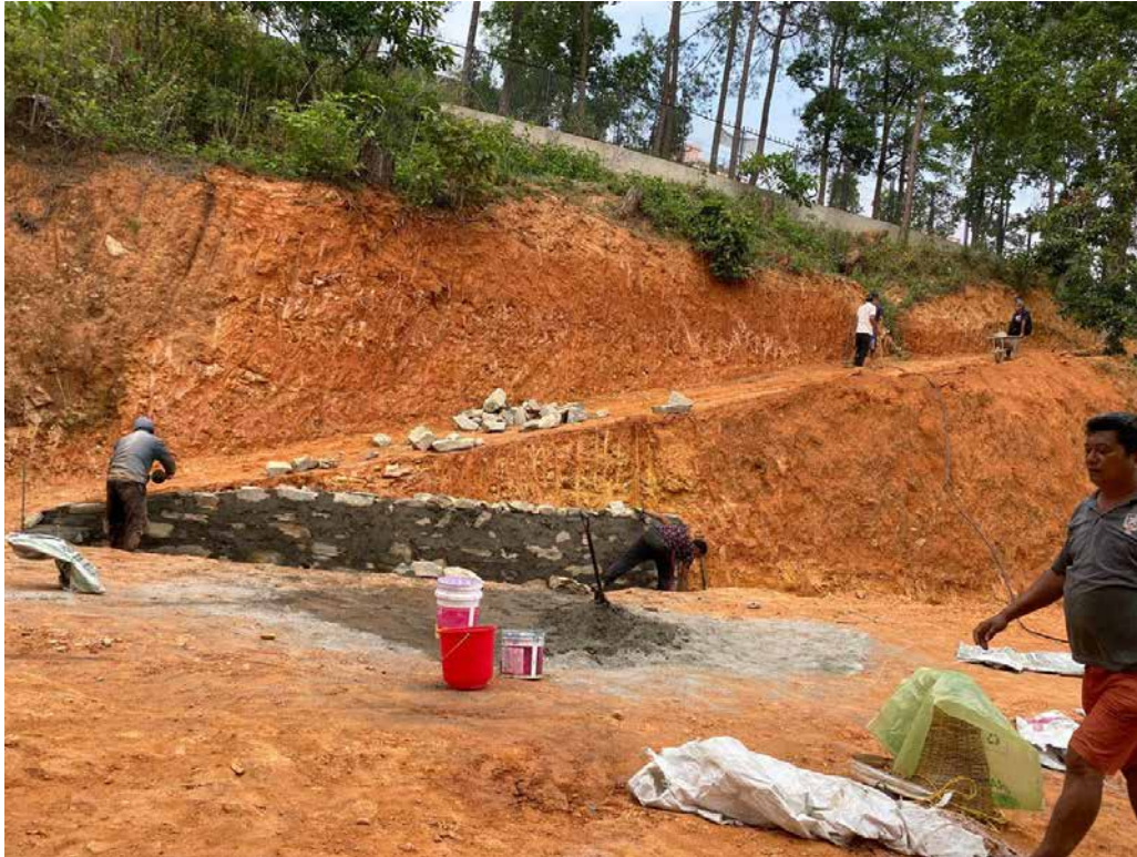
Abb: Bau einer Mauer von der Hauptstraße auf dem Weg zum Krankenhaus
