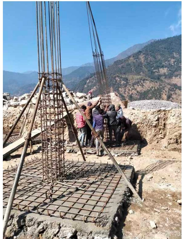
Vorbereitung der Bewehrung für das Fundament.
