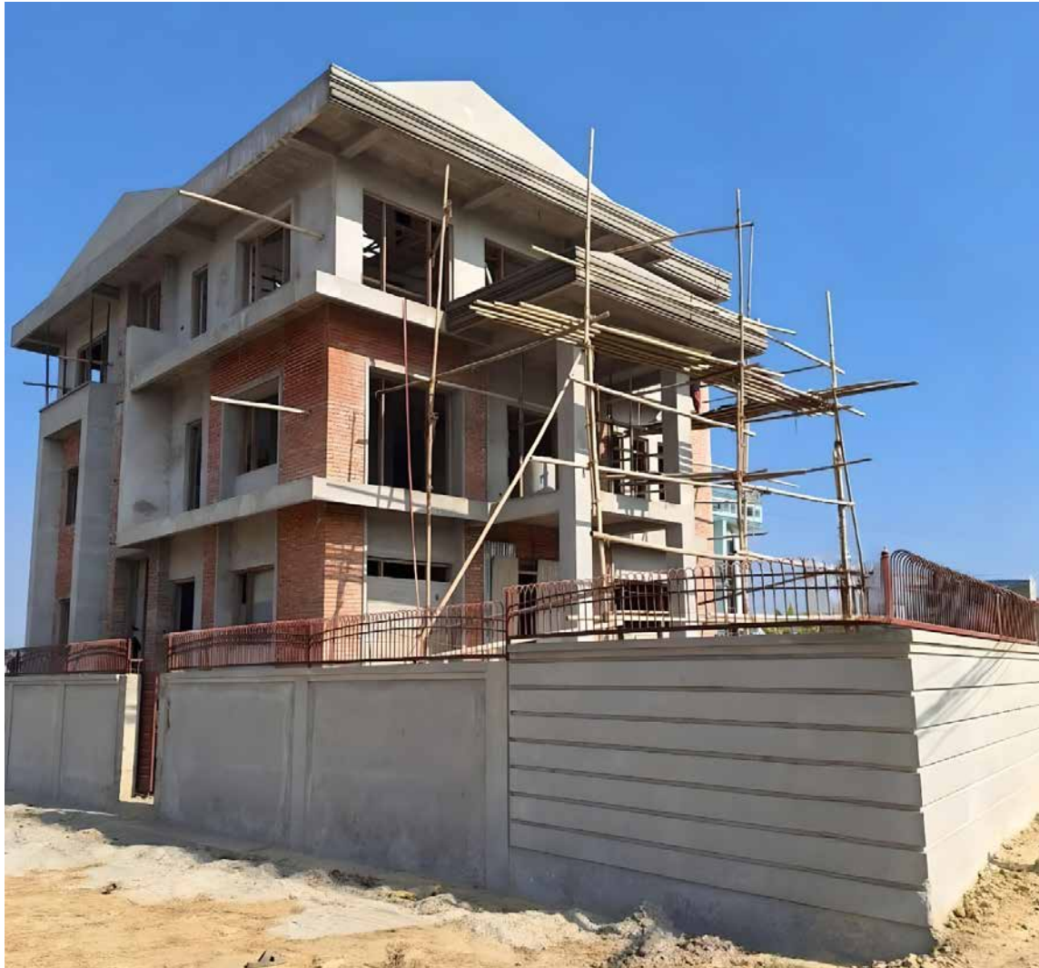
Foto: Vorder- und Seitenansicht des Gebäudes der Technischen Akademie
