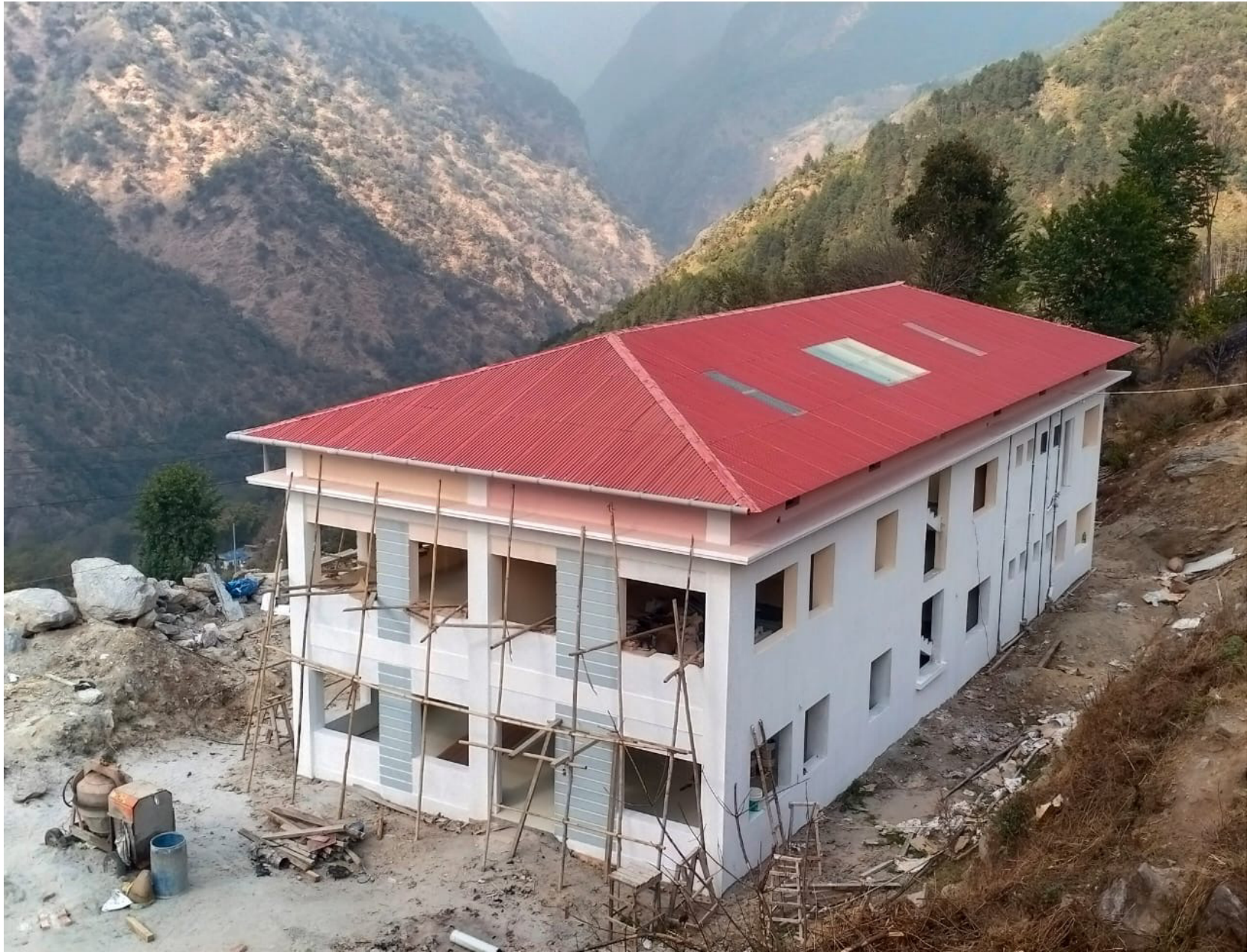
Fertigstellung der Dachmontage
