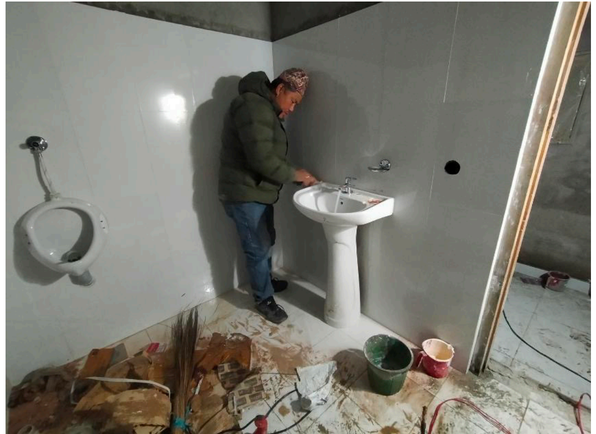
Installation von Waschbecken und Urinal
