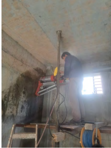
Foto: Klempnerarbeiten, Kernbohrarbeiten von Suresh Pahari
