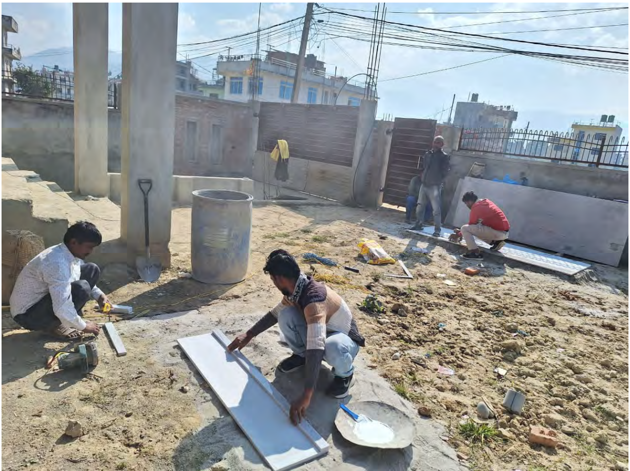
Foto: Granit Marmorarbeiten für das Treppenhaus
