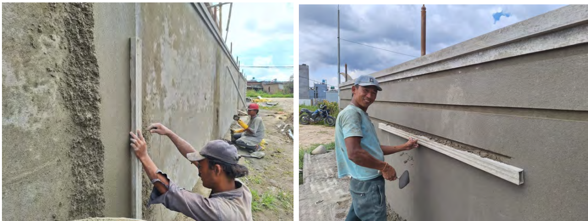
Foto: Endphase der Putzarbeiten
